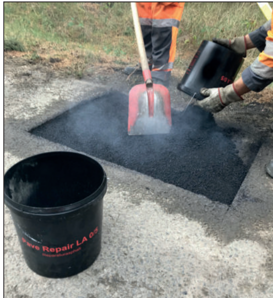
Bild 3: Mehrlagiger Einbau MPRS® (WMG)
