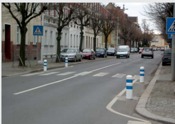
An Fußgängerüberwegen gemäß den Empfehlungen zur Gestaltung von Fußgängerwegen Richtlinien RFGÜ 2001 Pedestrian crossings
