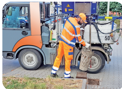
Sinkkastenreinigung mit selbstlernender Bestandserfassung
