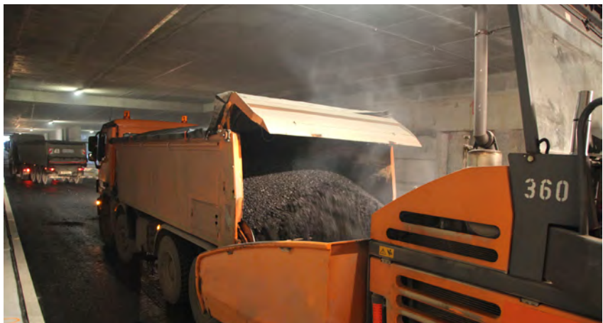
Zudem ist die Abschiebefunktion eine intelligente Lösung bei schwierigen Einbausituationen. Bäume, Oberleitungen, Brücken und Tunnel stellen kein Problem dar.
