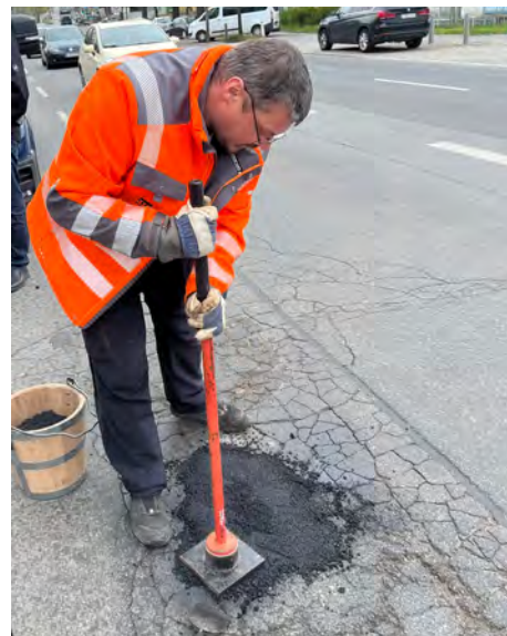
WMG und HMG kommen ohne Lösemittel oder Flux-Öle aus. Sie setzen sich ausschließlich aus Bitumen und Gesteinskörnungen zusammen.
