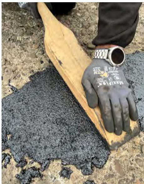
Die gewünschte Verarbeitungskonsistenz wird über die Erwärmung des Asphaltgranulates in mobilen Aufbereitungsanlagen direkt am Einbauort gesteuert.
