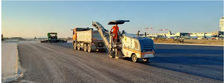
Gerade im Straßenbau ist es notwendig, auf langlebige Konzepte zu setzen, um die Umwelt zu schonen. Deswegen baut Fliegl auf Fahrzeuge mit Abschiebefunktion.
