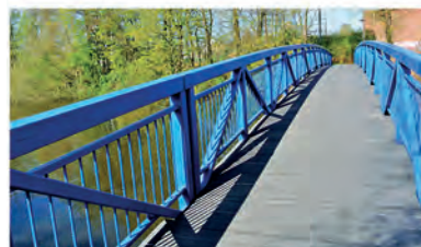
TRIMAX® als Brückenbelag
