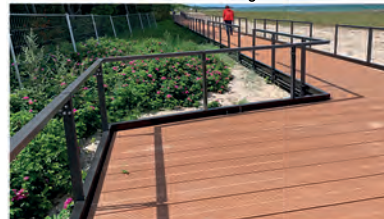
Steg am Strand aus TRIMAX®
