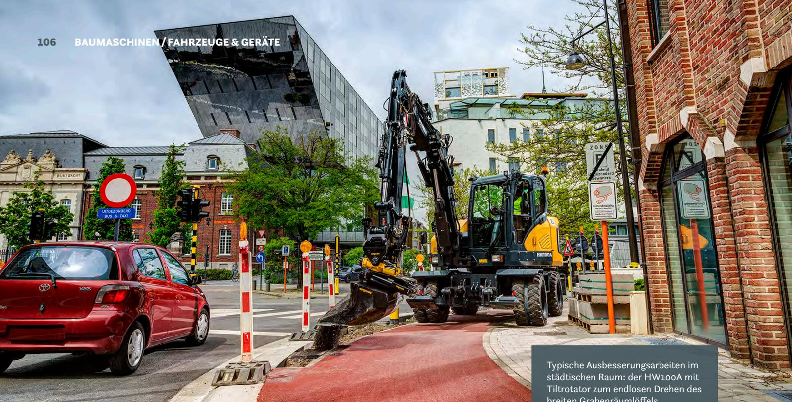
Typische Ausbesserungsarbeiten im städtischen Raum: der HW100A mit Tiltrotator zum endlosen Drehen des breiten Grabenräumlöffels.
