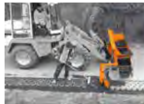
1,0 m³ Schaufel Rasengittersteine verfüllen
