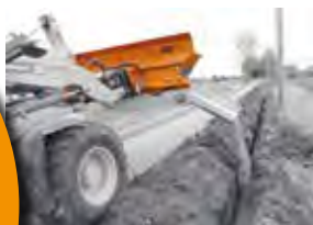
1,0 m³ Schaufel Leitungsbau – Graben verfüllen
