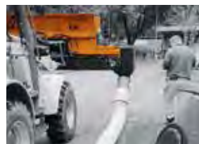
1,0 m³ Hochwasserschutz: Befüllen von Sandschläuchen
