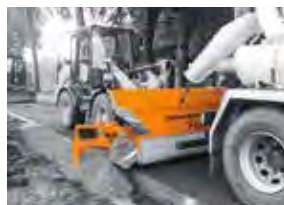
1,0 m³ Schaufel Randeinfassung: Fundamentverteilung u. Rückenstützbeton
