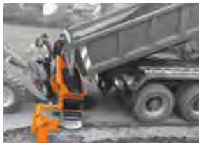
1,0 m³ Beladung direkt vom LKW
