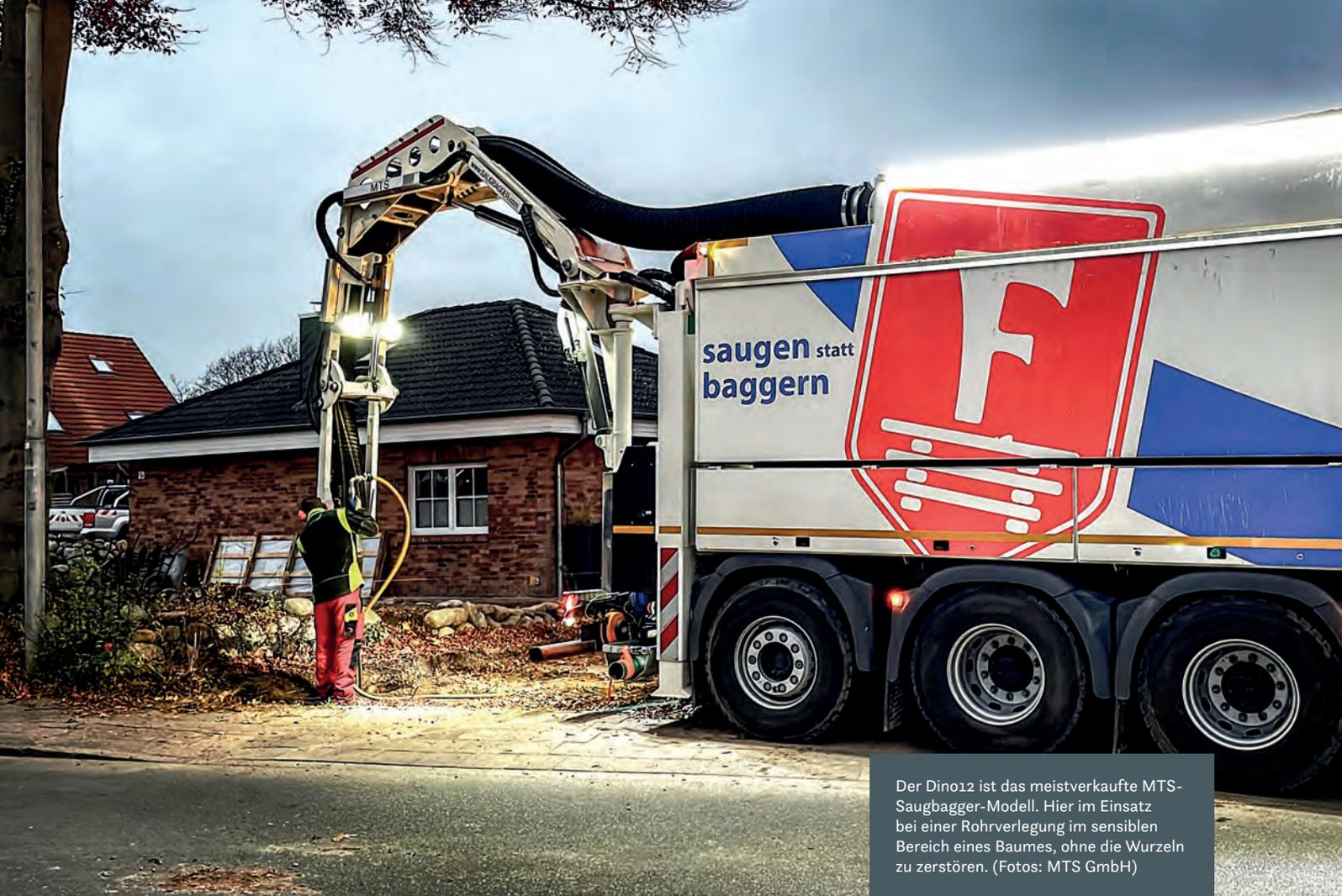
Der Dino12 ist das meistverkaufte MTS-Saugbagger-Modell. Hier im Einsatz bei einer Rohrverlegung im sensiblen Bereich eines Baumes, ohne die Wurzeln zu zerstören. (Fotos: MTS GmbH)
