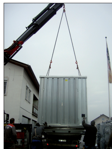
Kranösen erleichtern den Transport auf der Baustelle. Bild 26c90243
