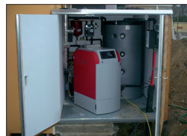
Anschlussfertig eingehaust: Mobile Heizzentrale im BOS Container. Weit öffnende Türen ermöglichen bequemen Zugang zur Technik. Bild 26c90241
