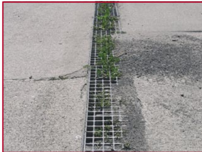
Reinigung von Entwässerungsrinnen
