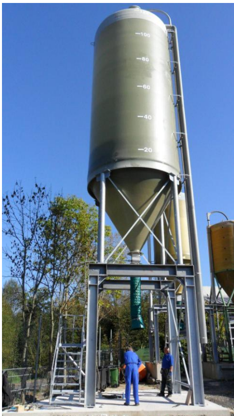
Silo Stadt Erbach
