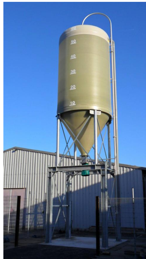
Silo Stadt Dieburg
