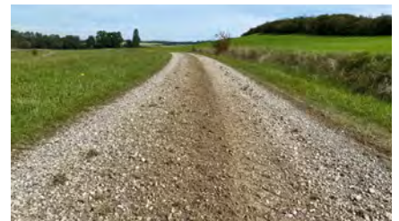
...und nach der Bearbeitung mit dem MS Grader Bull. Neben einer Begradigung lässt sich auch Bewuchs nachhaltig entfernen.
