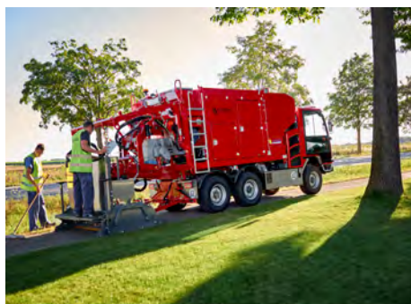
Der Mini-Mix A1,7 von schäfer-technic auf einem Kompaktfahrgestell verlegt DSK-Beläge auf schmalen Raum wie Radwegen.
