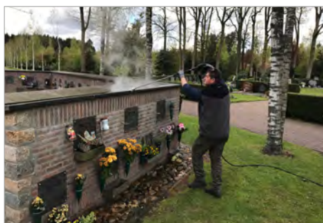
Beispielsweise zur Entfernung von Moos kann das BioMant-Heißwasser-System eingesetzt werden.
