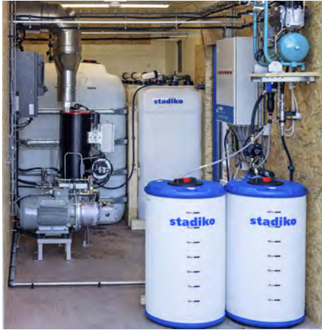
Das Herzstück ist eine zuverlässige frequenzgeregelte Heißwasser-Hochdruckanlage für zwei Anwender.
