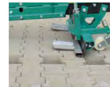
Abdrückfunktion erzeugt gute Verlegequalität
