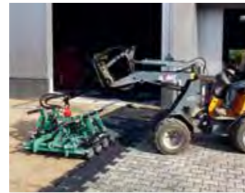
Pflastern mit Lader als flexible Alternative
