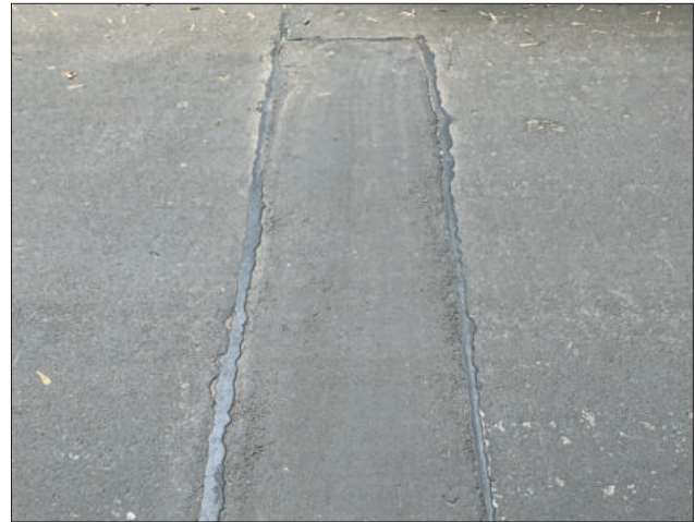
Bild 3: Sanierung mit Pave Repair HMG 5
