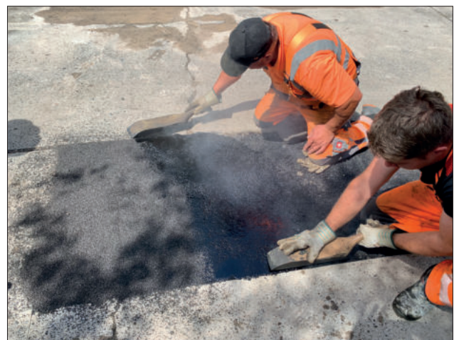
Bild 6: Einbau von Pave Repair HMG 8
