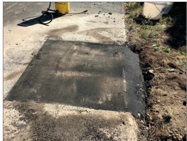
Bild 4: Instandgesetzte Fläche mit Pave Repair WMG 2
