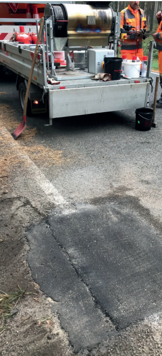
Bild 3: Mit MPRS® beseitigter Wurzelschaden am Fahrbahnrand
