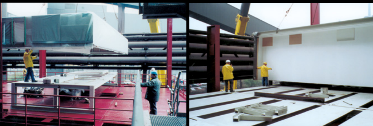
Schalhausmontage auf einer 6-Meter-Bühne in Duisburg-Nord.
