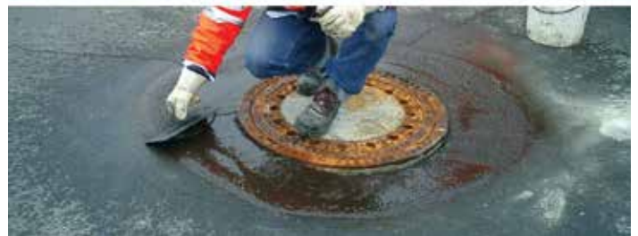
Verarbeitung von Flüssig Asphalt - Kein Fräsen erforderlich.
