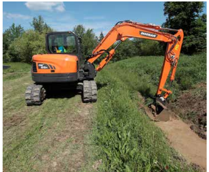
Der Doosan-Exavator-DX85R-3 Bagger im Einsatz.
