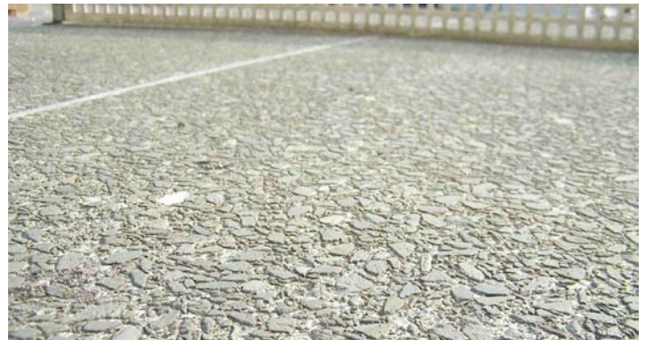
Ausgewaschene Zementbeton Oberfläche einer Tischtennisplatte.
