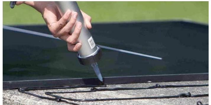
Auftrag der Fixiermasse auf die Betonoberfläche.
